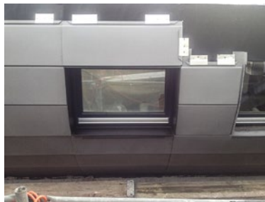
Anbringen der Flatlock-Profile auf der Holz-Unterkonstruktion
