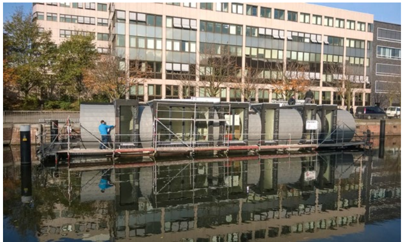
Baustelle auf dem Wasser: Bekleidung der gewölbten und planen Oberflächen
